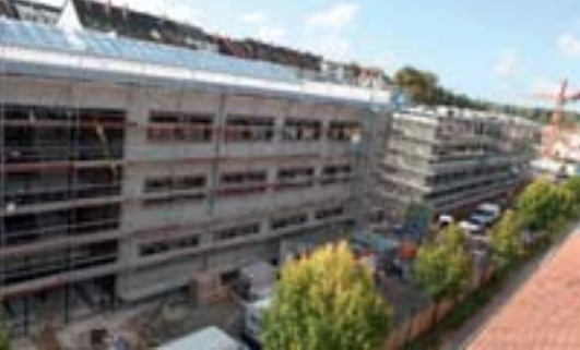
Blick auf die Baustelle
