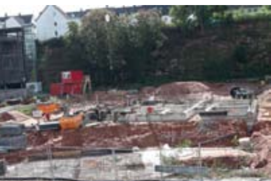
Das Fundament der Mensa
