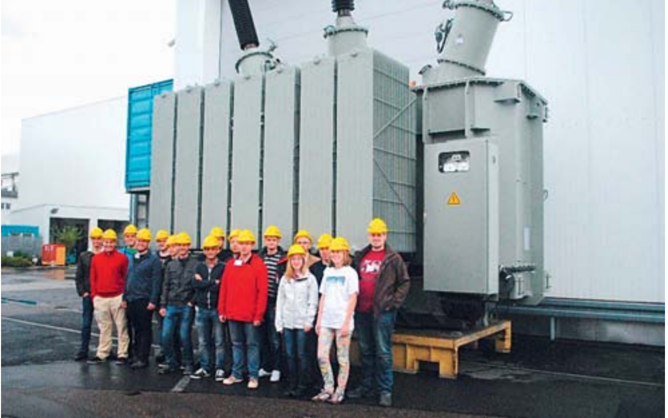
Siemens-Transformator (Foto: Prof. Glöser)
