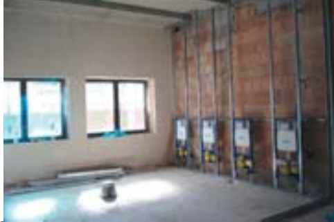
Hier entsteht ein Sanitärbereich
