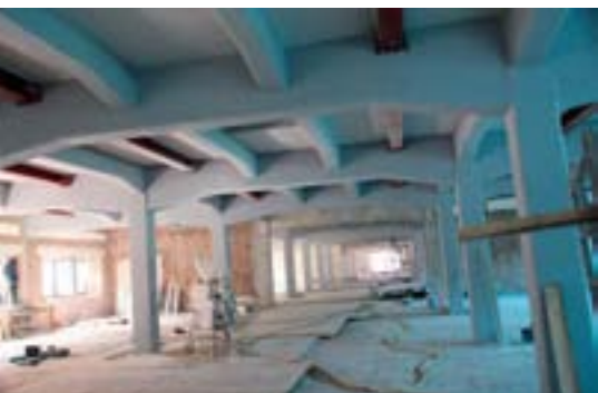
Hier entstehen Vorlesungsräume. Tragwerk und Decke wurden für die Statik und den Brandschutz durch eine Betonsanierung ertüchtigt
